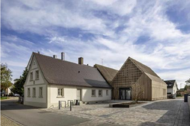
Gemeindebibliothek Gundelsheim (Architektur: Schlicht Lamprecht Architekten PartGmbH), Beispiel für Zusammenspiel von Alt und Neu
