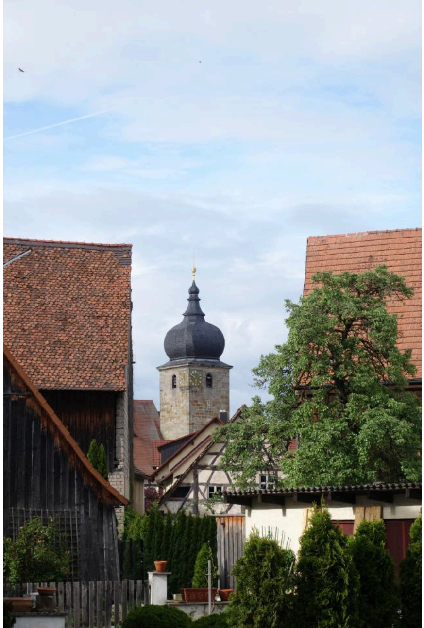
Blick von der Hauptstraße durch den Ortskern zur Kirche Bild: msh stadtplanung GbR
