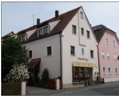
Einziges Lebensmittelgeschäft in der Gemeinde Langensendelbach, Hauptstraße 3 Bild: msh stadtplanung GbR
